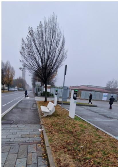
Descrizione prestazionale possibile intervento: Realizzazione di area pavimentata a lato di seduta esistente, larghezza minima area non inferiore a 150 cm di profondità e 110 cm di larghezza.
