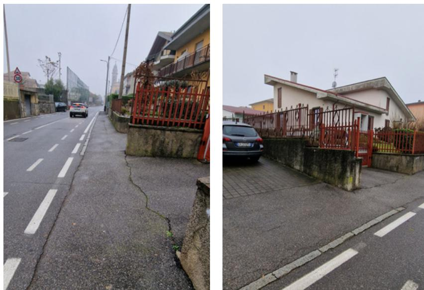
Descrizione prestazionale possibile intervento: Rifacimento del marciapiede o percorso pedonale esistente previa demolizione della pavimentazione compreso il sottofondo. Il nuovo piano di calpestio dovrà risultare compatto, omogeneo con pendenza trasversale non superiore all'1%.
