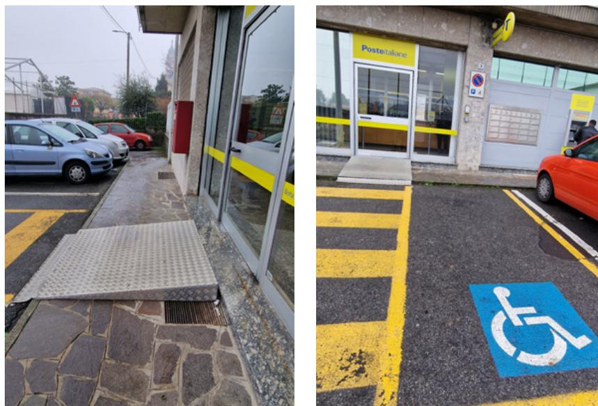
Descrizione prestazionale possibile intervento: Rifacimento del marciapiede o percorso pedonale esistente previa demolizione della pavimentazione compreso il sottofondo, allo scopo di creare un'area sopraelevata in corrispondenza dell'accesso sopraelevato, realizzando una doppia rampa longitudinale al senso di percorrenza del marciapiede, laddove possibile di pendenza non superiore al 5%.
